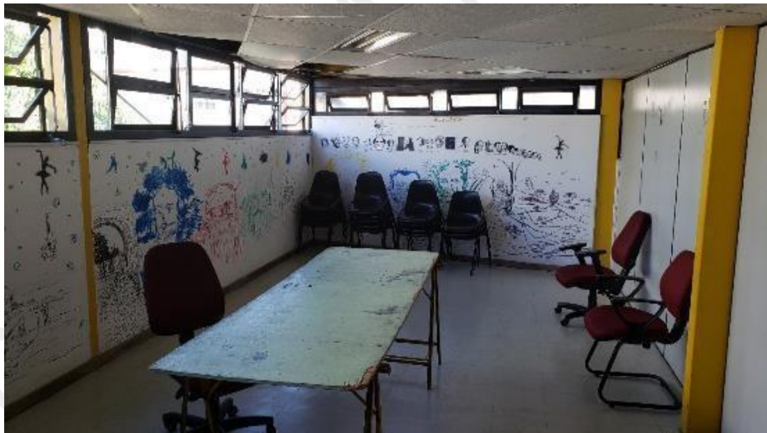
Figura 62 – Sala de oficinas – Casa de Cultura Freguesia do Ó
