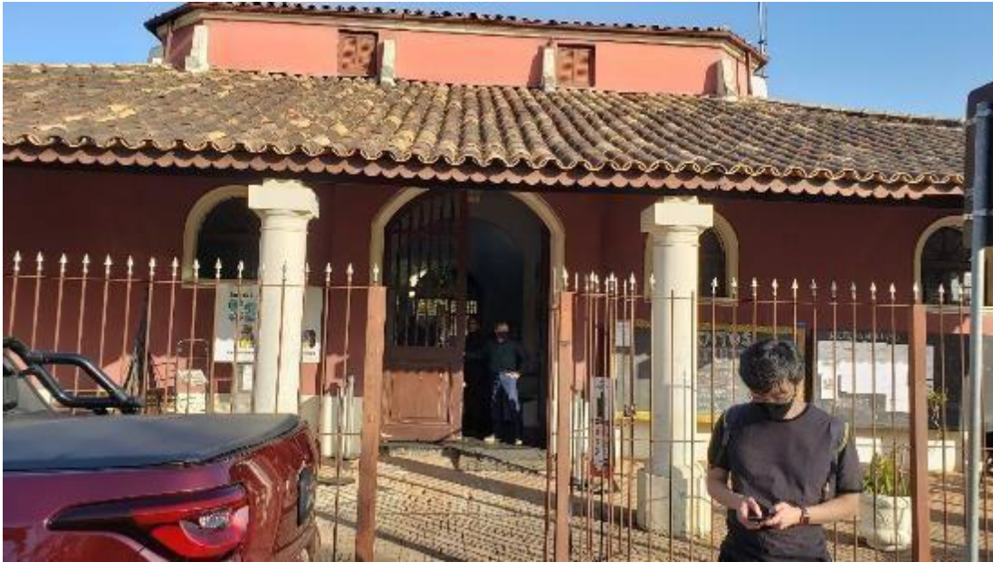
Figura 106 - Fachada - Casa de Cultura Manoel Mendonça
