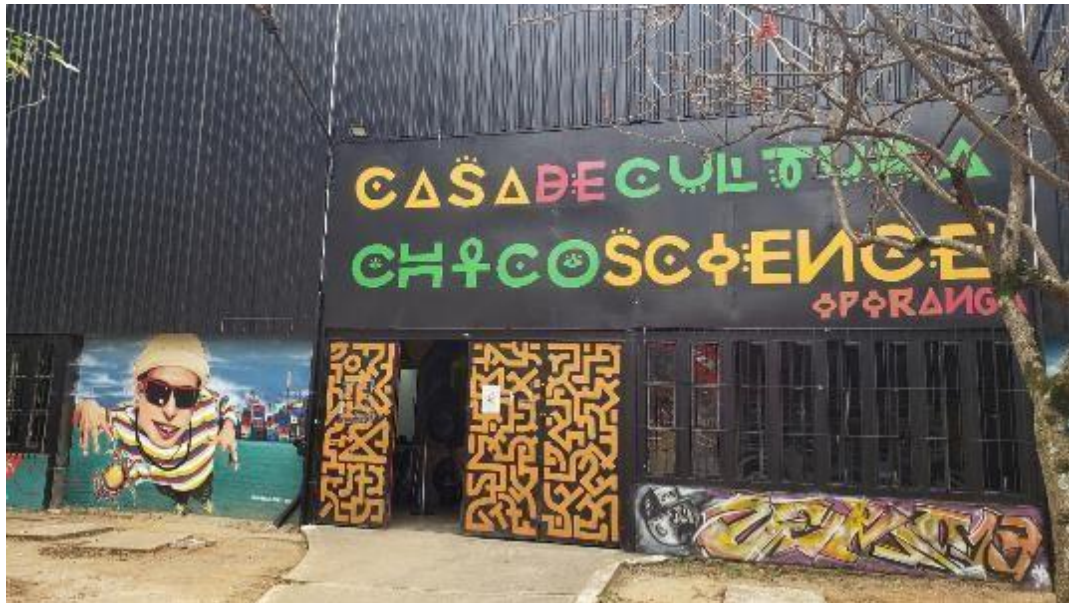
Figura 111 - Fachada - Casa de Cultura Ipiranga
